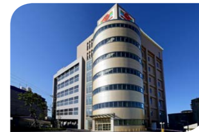
平鎮 - 製造新廠與辦公新廠 已於 2016 年第三季完工
