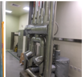
蒸汽冷凝水回收設備
