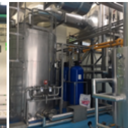
蒸汽冷凝水回收桶槽
